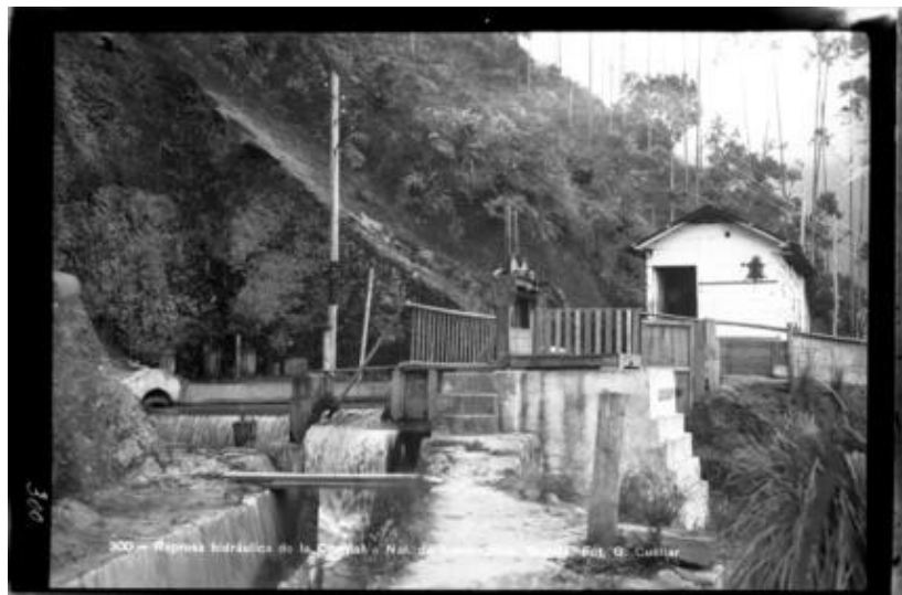
Figura 2. Represa de la Compañía Nacional de Electricidad (Archivo Banco de la Republica).
