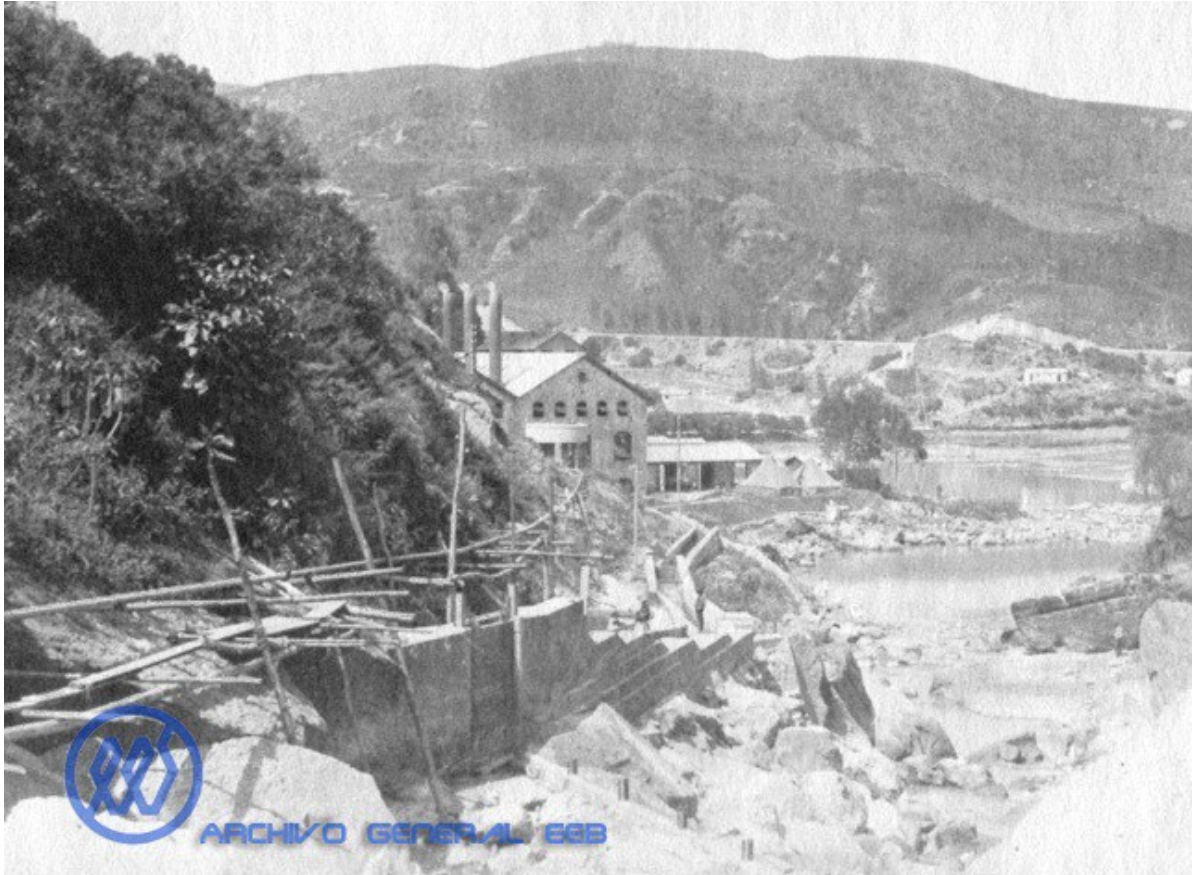
Figura 1. Construcción represa “El Charquito” (Archivo Empresa de Energía de Bogotá).
