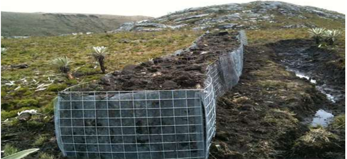
FOTOGRAFÍA 1 MURO DE CONTENCIÓN HECHO POR EL EJÉRCITO NACIONAL CON MALLA, PLÁSTICO Y TIERRA. LAGUNA LOS MORTIÑOS (TOMADO DE DELGADO, Y, 2015)
