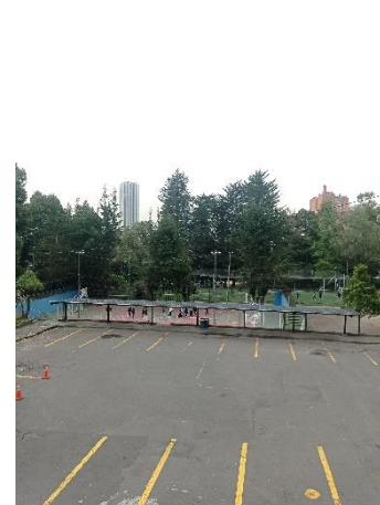
Figura 2: Paneles solares del parqueadero II
