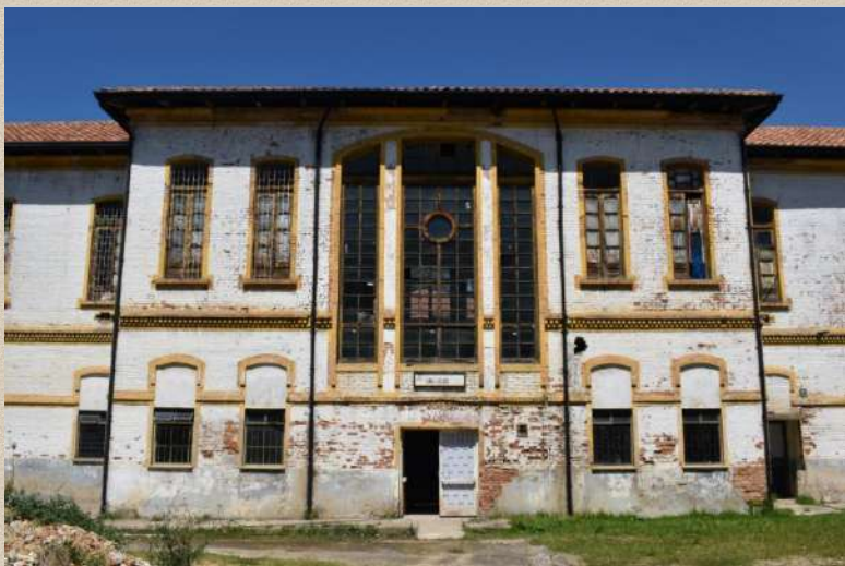
Fotografía del edificio San Lucas, Romero Y., "Sin título", 2023.
