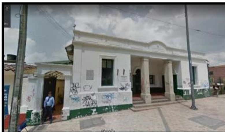
Ilustración 26. Sede del CIMS en la década del 2000. Recuperado del trabajo de Yopasá (2019)
