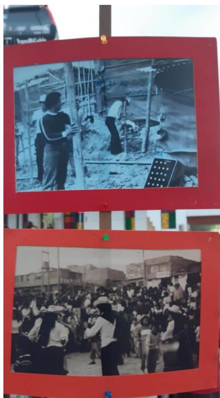
Fotografía de inicios de construcciones en el barrio Juan Pablo II y encuentros culturales Fuente: Muro de la memoria (2022)
