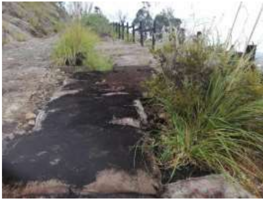
Foto 4 proceso de revegetalización de suelos degradados con biomantos. Área de Importancia Ambiental Soratama. Bogotá-Colombia.
