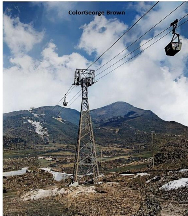
Cable aéreo de la fábrica la Siberia 4
