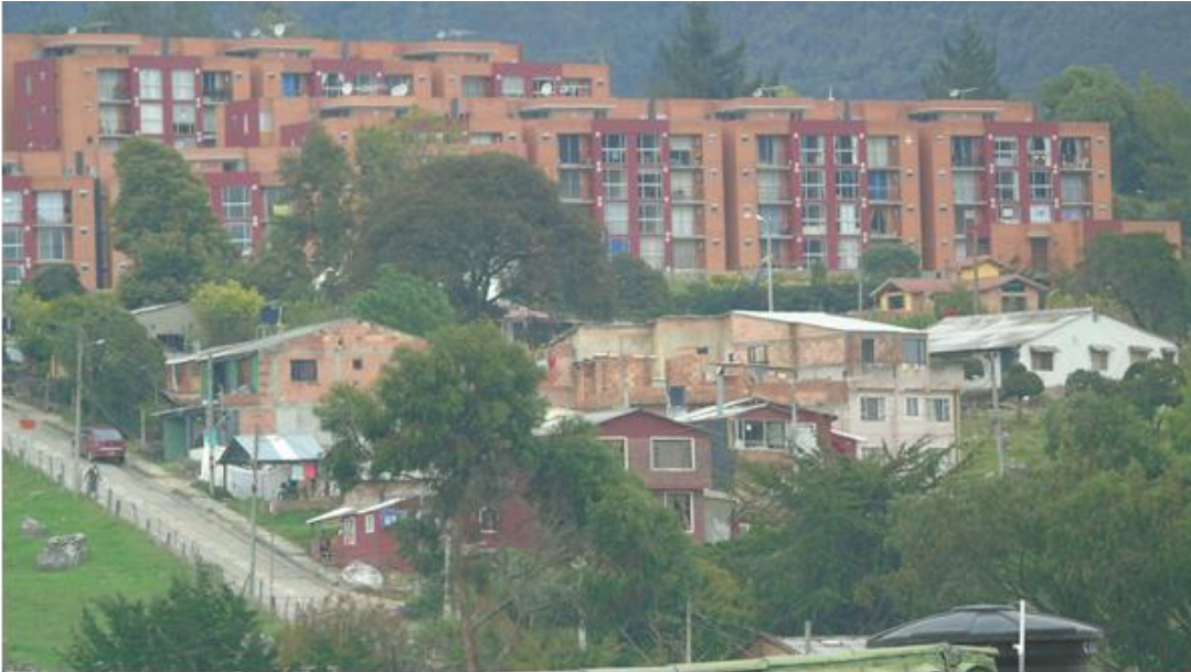
Aparición del conjunto residencial el pórtico en el centro poblado de la vereda Altamar Nota: Elaboración propia
