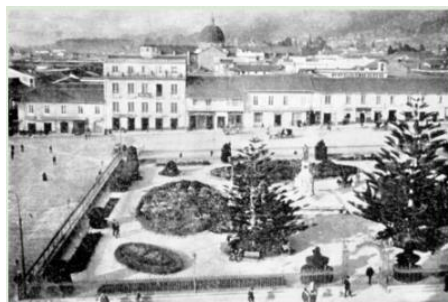
Plaza de Bolívar, vista desde el costado sur con el portal de entrada y las araucarias cecobas. Se observan los tapetes rectos interrumpidos por árboles salicarios. Archivo DMOB, registro XVI-1046c
