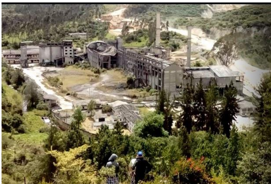
Ilustración 6. Visita guiada a las ruinas de la fábrica Cementos Samper
