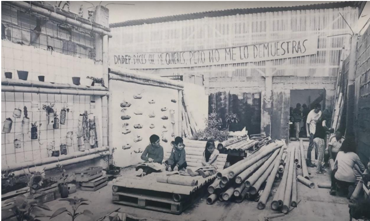
Construcción de la Casa Cultural El Trebol, 2015. [Fotografías tomadas de video]
