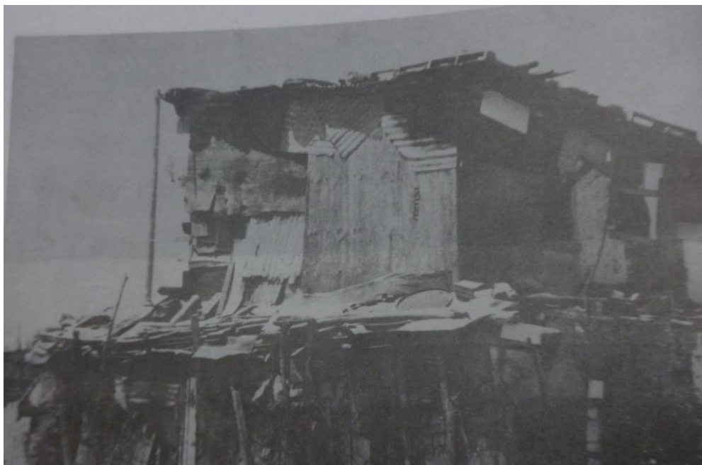
Fotografía 9: Residencia autoconstruida siglo XX.
