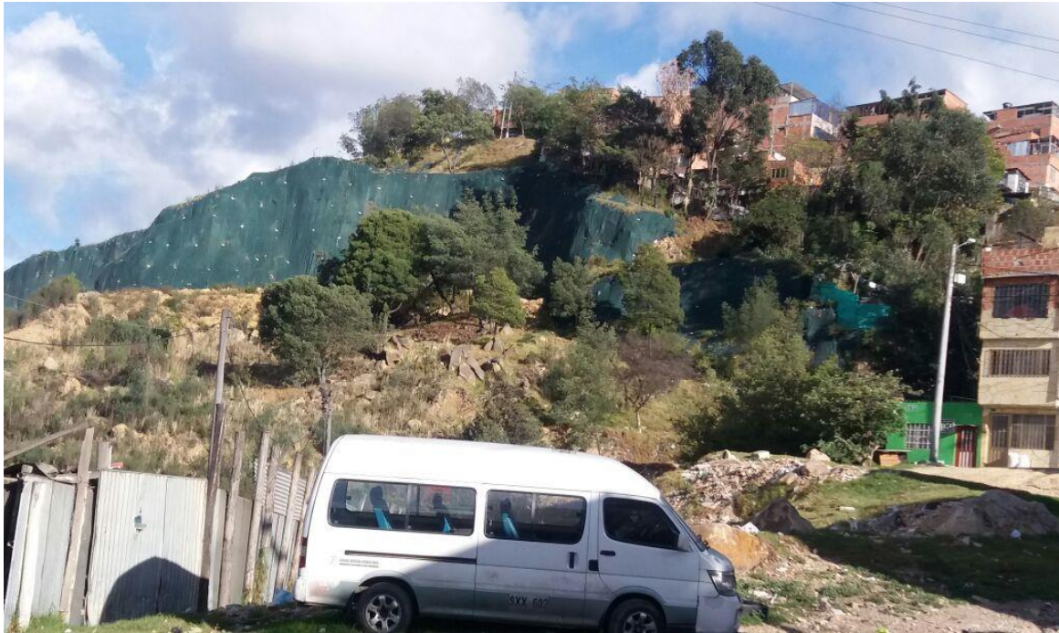
Fotografía 34: Edificación de viviendas en zonas de riesgo.
