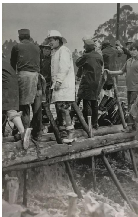
Ilustración 15. Inundación de Patio Bonito.
