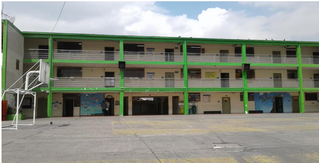
Fotografía N° 2 Interior de la Sede B del Colegio ITIP
