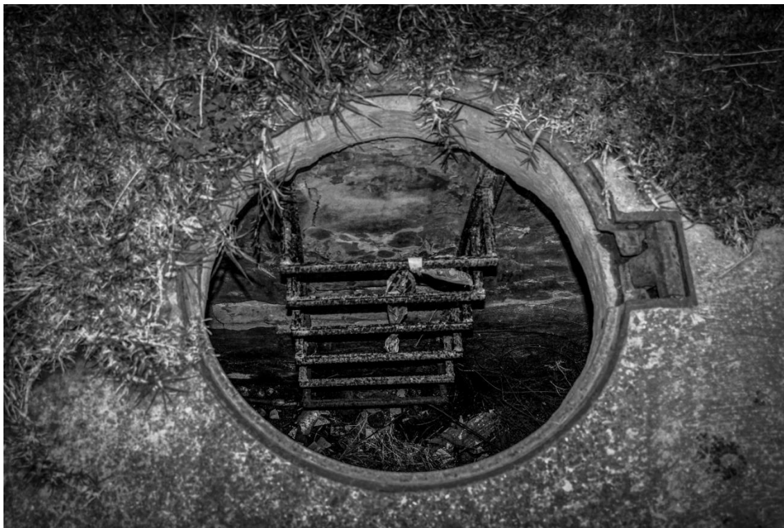
Fotografía. 4. Instalación de redes de Alcantarillado.
