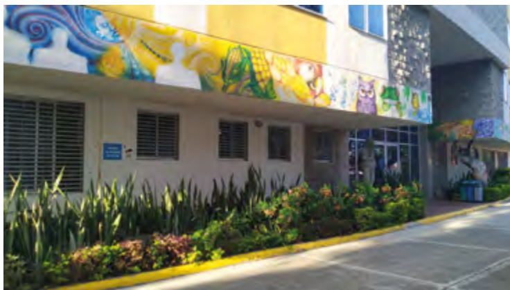
Figura 1. Sede central y exteriores Edificio de Artes, sede central de la Universidad Surcolombiana.
