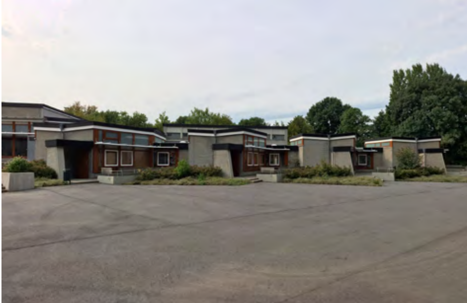
Figura 6. Escuela construida por Hans Scharoun
