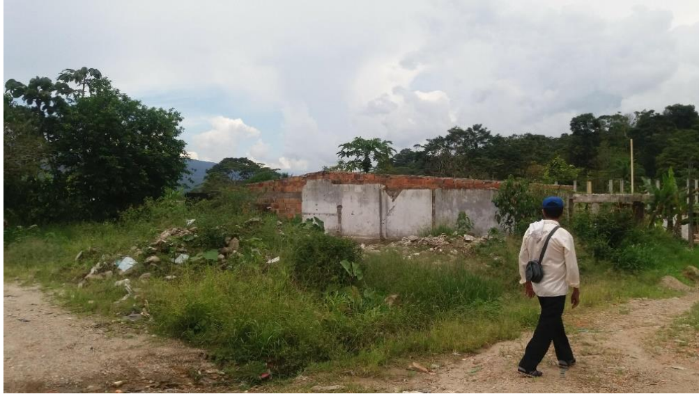
Ilustración 12 Lo que fue el Hogar de Juan Rodríguez Convertido en Escombros. Fuente propia. Octubre 19 de 2018
