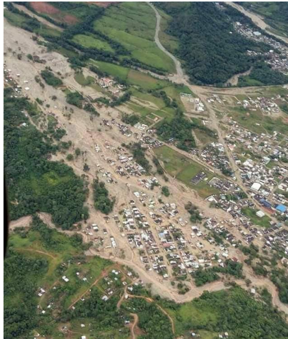
Ilustración 11 Fotografía aérea de Quebrada Taruca, parte alta de Mocoa, barrios arrasados Los Pinos, San Miguel y Laureles por la avalancha fuente: Vilmer Quiroz, (Mocoa 2 de abril del 2017).
