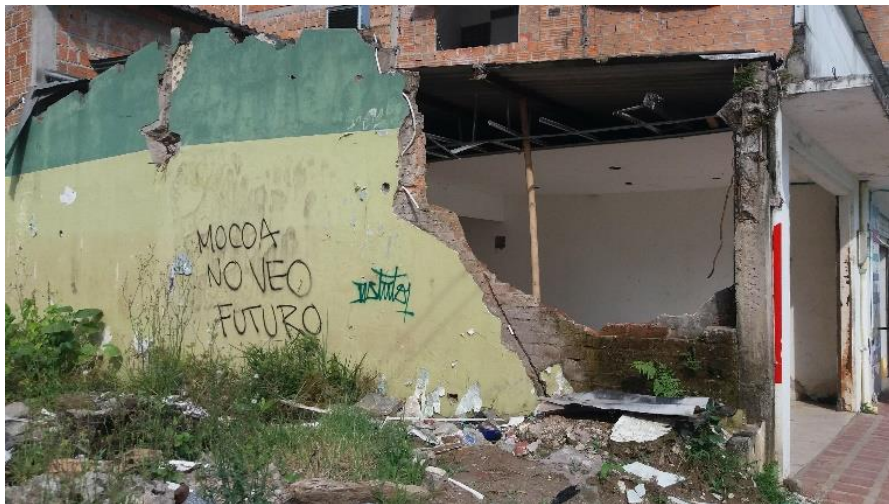
Ilustración 8 Los muros comunican. fuente propia (octubre19 de 2018)
