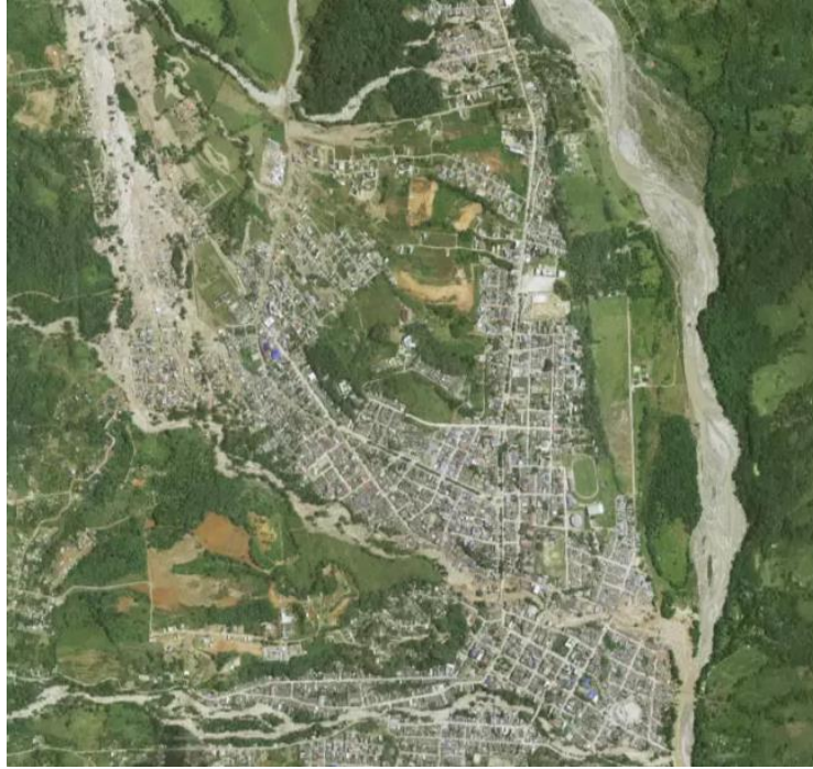
Ilustración 15 Fotografía aérea posterior de la avalancha fluviotorencial del 31 de marzo, Fuente: Corpoazonía. (4 de abril de 2017). Geospatial. Obtenido de Geospatial: http://www.geospatial.com.co/mocoa/compareOne.html
