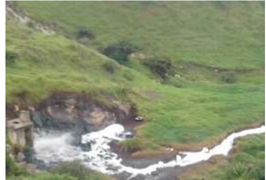
Fotografía 3 desagüe Laguna Terreros (Franco, 2019)
