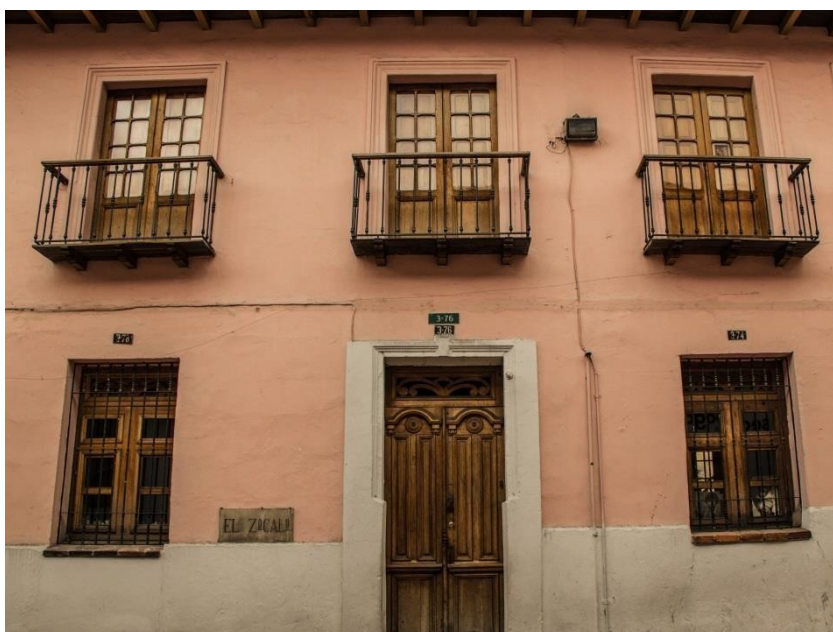
(Imágenes 8, 9 y 10). Detalles de viviendas en el barrio la Candelaria (fotografía de Alejandro Ríos, Bogotá, 2018)
